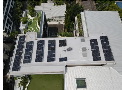
ภาพที่ 2.2-38 การติดตั้งระบบเซลล์แสงอาทิตย์ (Solar Cell) ของโครงการ
