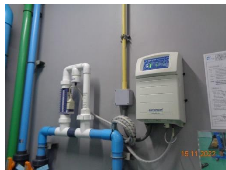
ภาพที่ 2.2-22 ระบบเกลือของสระว่ายน้ำ
