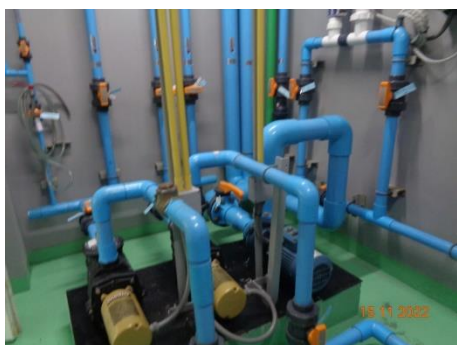
ภาพที่ 2.2-22 ระบบเกลือของสระว่ายน้ำ
